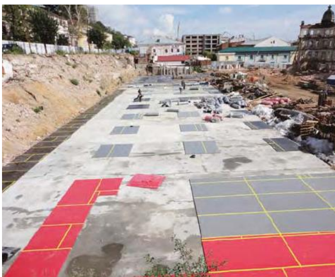
Рисунок 2.9 – Применение виброизолирующих матов при строительстве зданий
