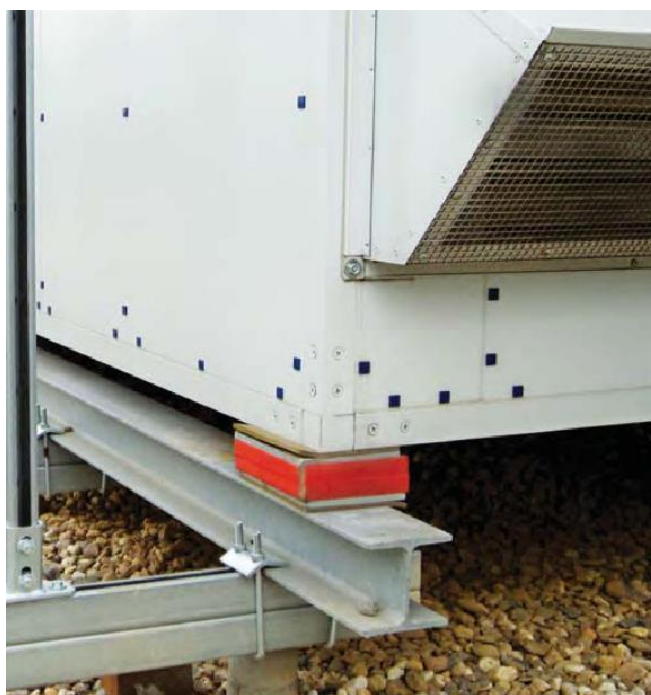
Рисунок 2.10 – Виброизоляция инженерного оборудования
