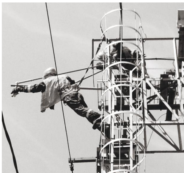
Рисунок 4.1–Производство работ по замене кронштейна
