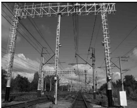
Рис. 8.6. Электронные габаритные ворота
