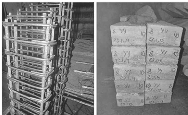
Рис. 2. Пространственный арматурный каркас и результат бетонирования балок
