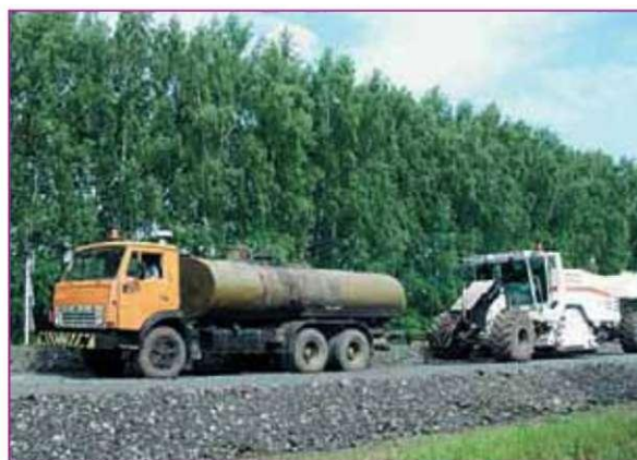
Рис. 7. Холодная регенерация дорожной одежды ресайклером RACO-550
