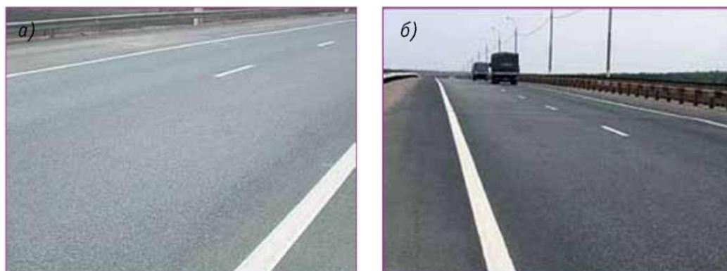
Рис. 9. Характеристика готового покрытия: а – отсутствие отраженных и температурных трещин на асфальтобетонном покрытии; б – высокое качество дорожного покрытия
