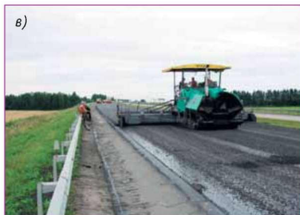
Рис. 8. Мембранная технология устройства дорожных покрытий. Стадии работ:
