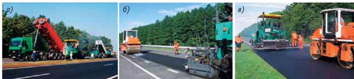
Рис. 4. Устройство тонкослойного асфальтобетонного покрытия «Новачип»:
