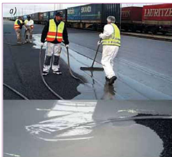
Рис. 10. Полу жесткие покрытия дорог на участках с особо тяжелыми условиями эксплуатации: а – устройство цементоасфальтобетонного покрытия логистического центра; б – керн, взятый из цементоасфальтобетонного покрытия площадки логистического центра
