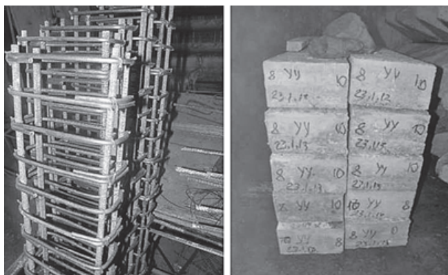
Рис. 2. Пространственный арматурный каркас и результат бетонирования балок
