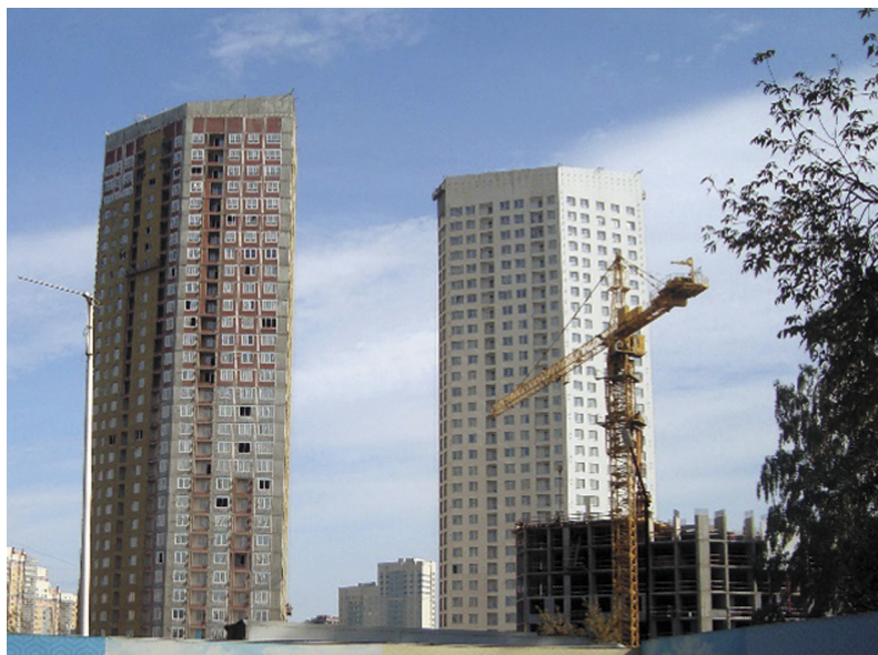
Рис. 5. 105-метровый жилой дом (слева), фундаменты которого запроектированы в соответствии с требованиями ст. 16 Федерального закона № 384-ФЗ; справа такие же дома на свайных фундаментах
