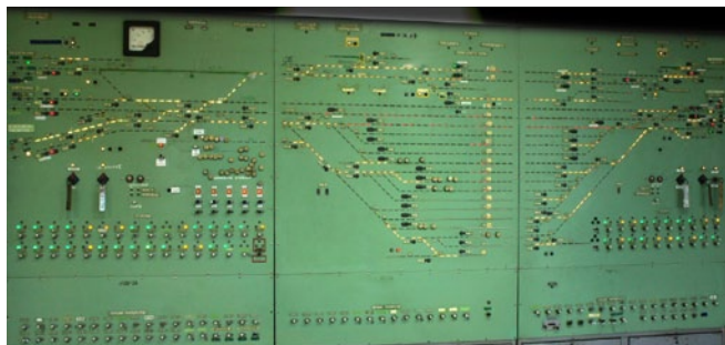
Рисунок 1 — Внешний вид табло отдельного аппарата управления релейной ЭЦ
