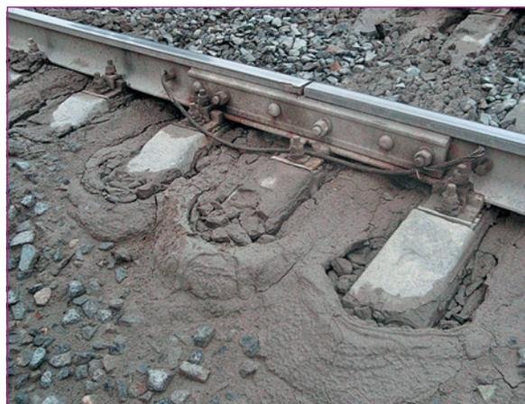
Рис. 3. Состояние балластной призмы при использовании песка машинистами поездов (перегон Григорьевская — Чайковская, нечетный путь, км 1369–1386)
