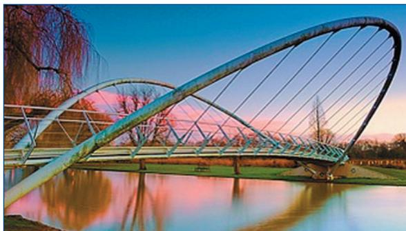
Рис. 5. Мост-бабочка с двумя наклонными арками
