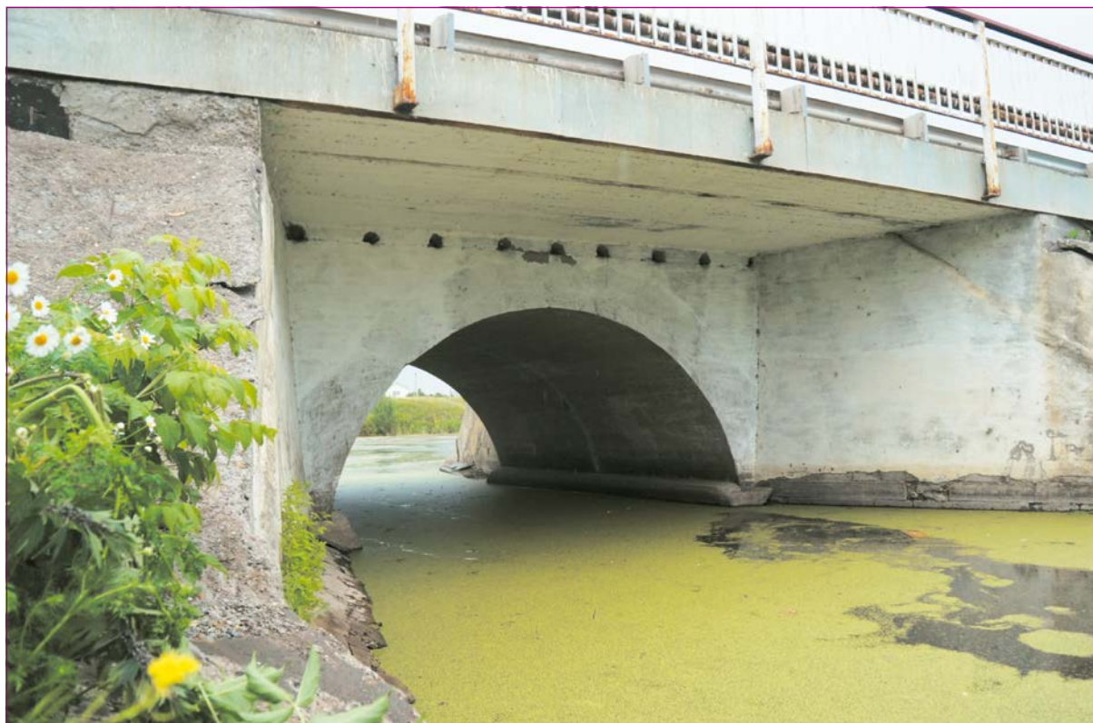
Мост через ручей на км 58+539 автомобильной дороги Казань – Оренбург. Средняя часть моста арочная бесшарнирная, постройки 1907 г. В 2005 г. произведено уширение пролетного строения ж/б плитами с обеих сторон
