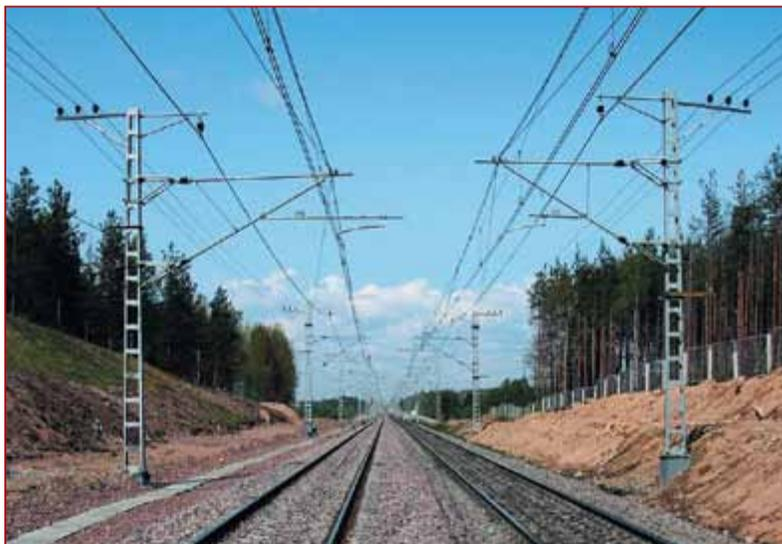
Рис. 1. Контактная сеть КС-200-06 разработки УКС на участке Санкт-Петербург – Выборг
