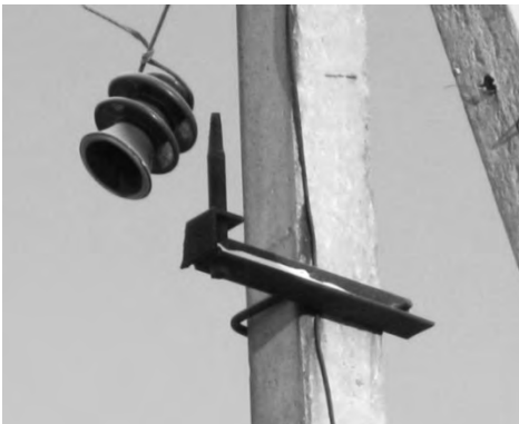
Рис. 3. Дефекты поддерживающих конструкций ВЛ а – срыв изолятора со штыря; б – разрушение кронштейна в узле крепления
