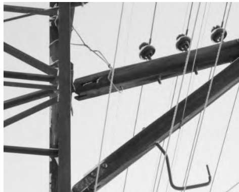
Рис. 3. Дефекты поддерживающих конструкций ВЛ а – срыв изолятора со штыря; б – разрушение кронштейна в узле крепления
